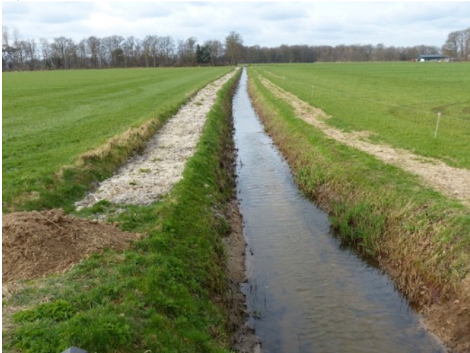
13 idem bij een zijwatergang van de Vierakkerse Laak. Nog één baggerbeurt en het schouwpad kan weer bij het perceel.
