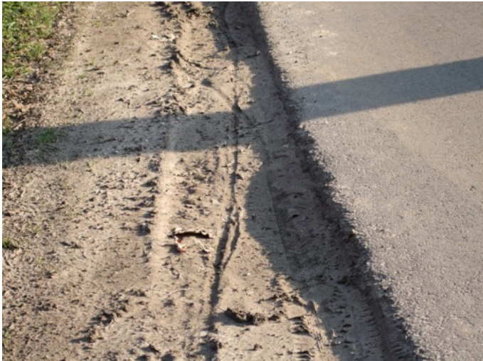
34 hoge asfaltranden vormen een serieus risico voor fietsers
