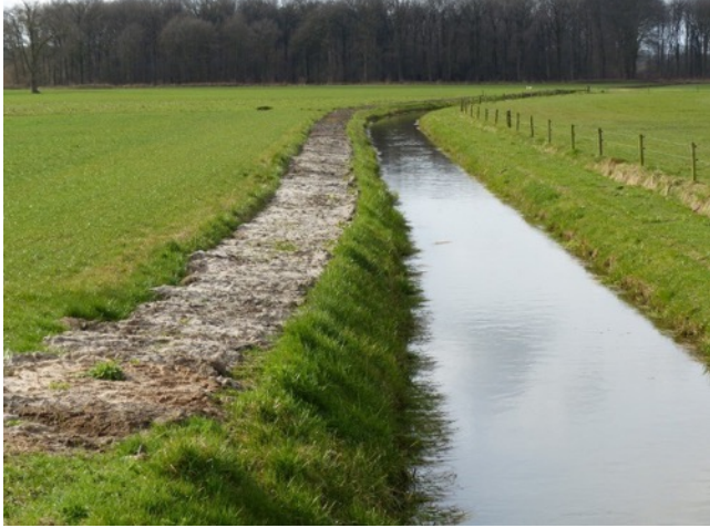
12 Vierakkerse laak een beetje extra uitgediept en het schouwpad opgehoogd
